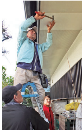
軒天井の補修作業
